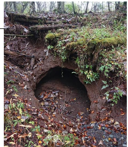
飽和状態になり吹き出した地下水噴出孔（パイプ）（2021年10月）
