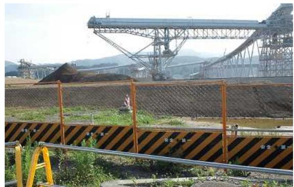
写真-22：盛土用の土砂を運ぶベルトコンベア
