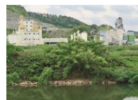
図 8 セメント工場
