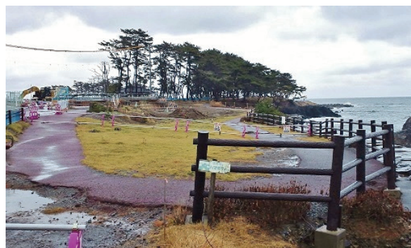
2017年1月 工事の始まった岩井崎の海岸。
